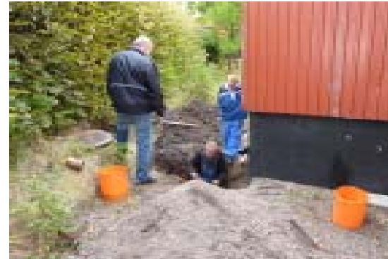
Fra Arbejdsdag i oktober. Alex og Freddy graver afløbet frit. Pilen havde sendt sine rødder ind i afløbet, som var totalt stoppet til.
